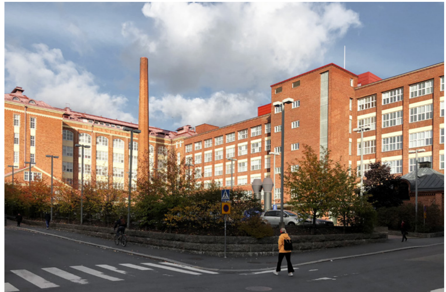
Pinninkadun ja Tullikadun risteyksen nykytilanne
